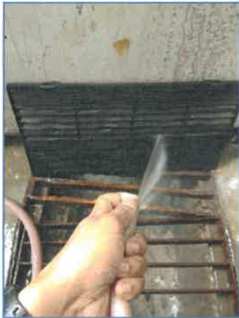
ภาพถ่ายที่ 2.2-32 การทำความสะอาดเครื่องปรับอากาศ
