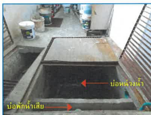
ภาพถ่ายที่ 2.2-13 บ่อน้ำและบ่อพักน้ำเสีย พร้อมตะแกรงดักมูลฝอย
