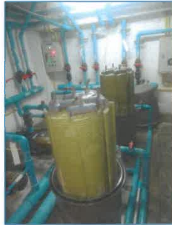
ภาพถ่ายที่ 2.2-11(2) การล้างทำความสะอาดถังน้ำใช้และระบบกรองน้ำใช้ (ต่อ)
