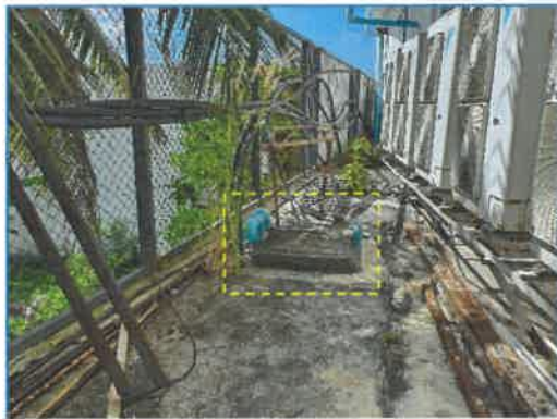
ภาพถ่ายที่ 2.2-16(2) ระบบท่อ vent พิธีเพื่อระบาย ก๊าซมีเทน
