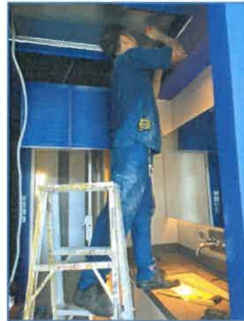
ภาพถ่ายที่ 2.2-32 การทำความสะอาดเครื่องปรับอากาศ
